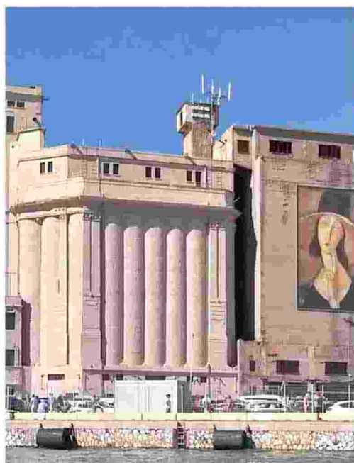
Il Silos costruito nel 1924, è stato uno dei primi edifici in cemento armato realizzati nel nostro Paese ed è rimasto attivo come luogo di stoccaggio merci fino alla fine degli anni '80
