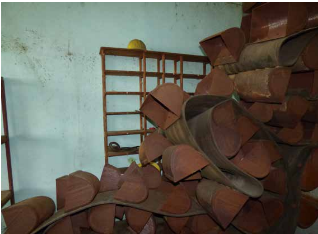
34. Sistema interno di trasferimento verticale con doppi nastri a tazza, particolare dei nastri smontati ed accatastati
