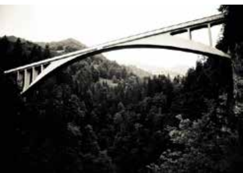
9. R. Maillart, Ponte in cemento armato sul torrente Salginatobel , Cantone Svizzero del Graubünden (1929)
