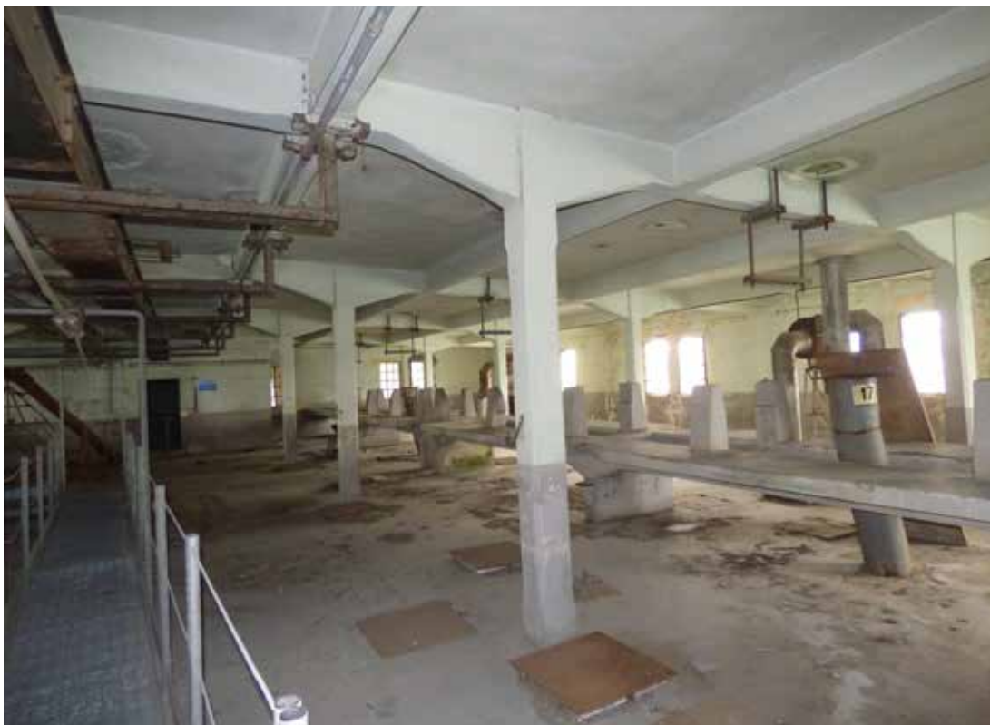
35. Sistema interno di trasferimento orizzontale al piano "sopra-celle". In questa zona sono purtroppo andati persi molti componenti metallici
