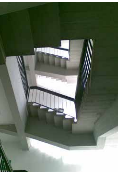
Sotto: 11. R. Morandi, Centrale Termoelettrica Selt-Valdarno di Livorno - Scala interna (1960)
