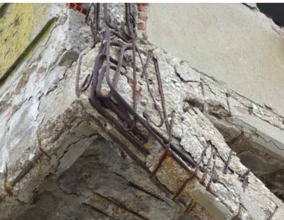
43. Dettagli dei degradi corticali del calcestruzzo
