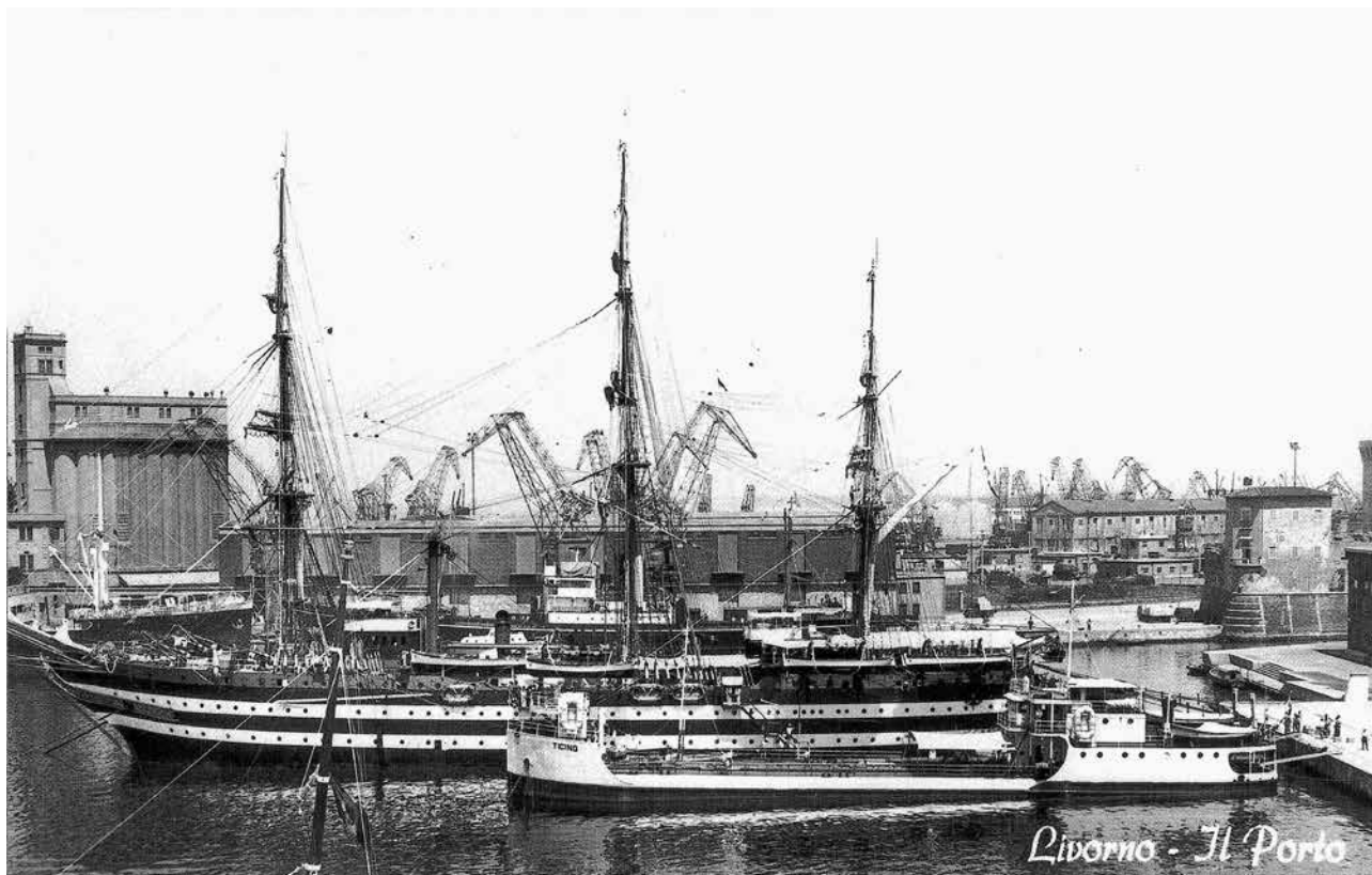
Il Silos ricostruito con Nave Vespucci all'ormeggio
