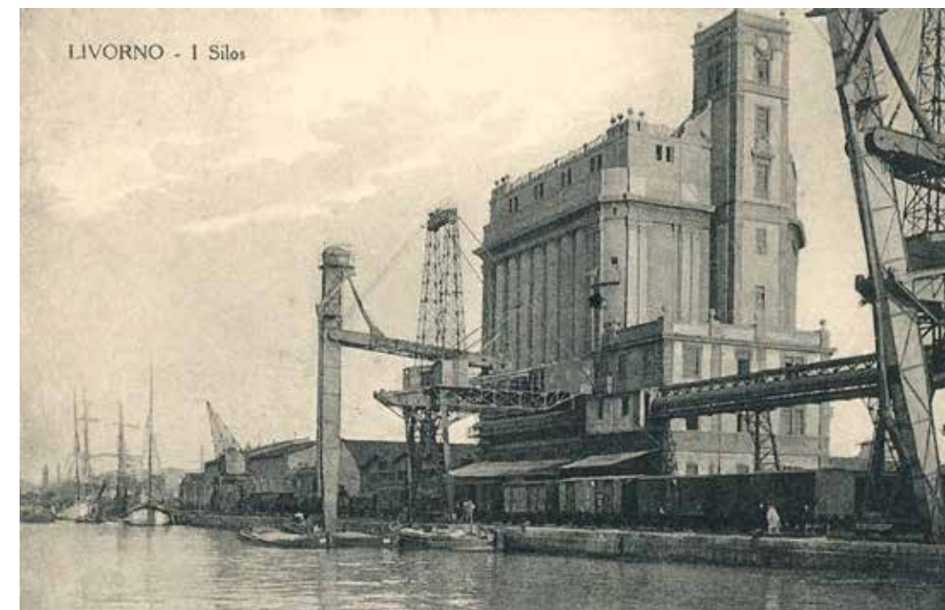
Il Silo granario e i «due grandiosi elevatori da nave» con «la grande incastellatura a capra zoppa autoscorrevole sulla banchina», coll. G. Mandalis
