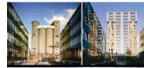
Georgi DAS SILO Hamburg, Germany 2006/08
