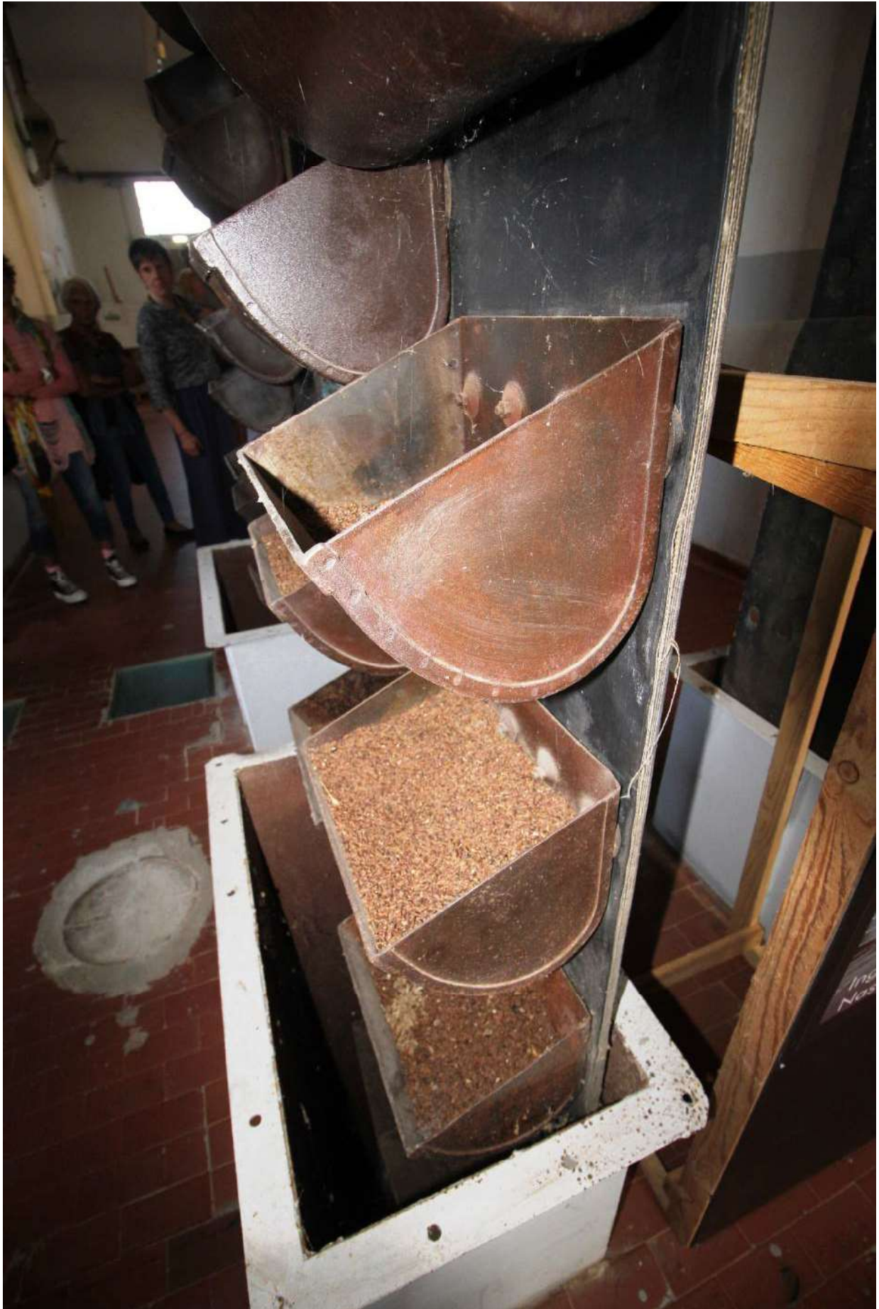
Elevatore continuo a tazze contenenti il grano
